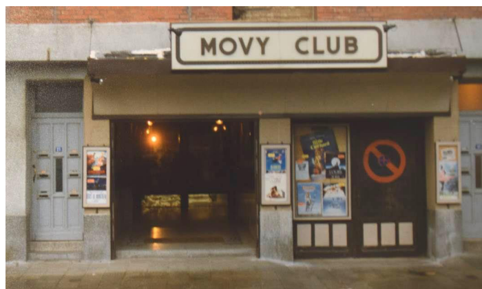
Photo auvent et enseigne existants, années 90
