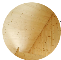
TRIANGLES + PLAFOND PANNEAUX CLT
