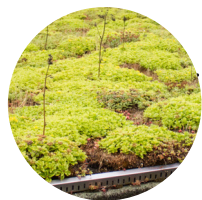
FINITION TOITURE ISOLANT + T. VERTE EXTENSIVE
